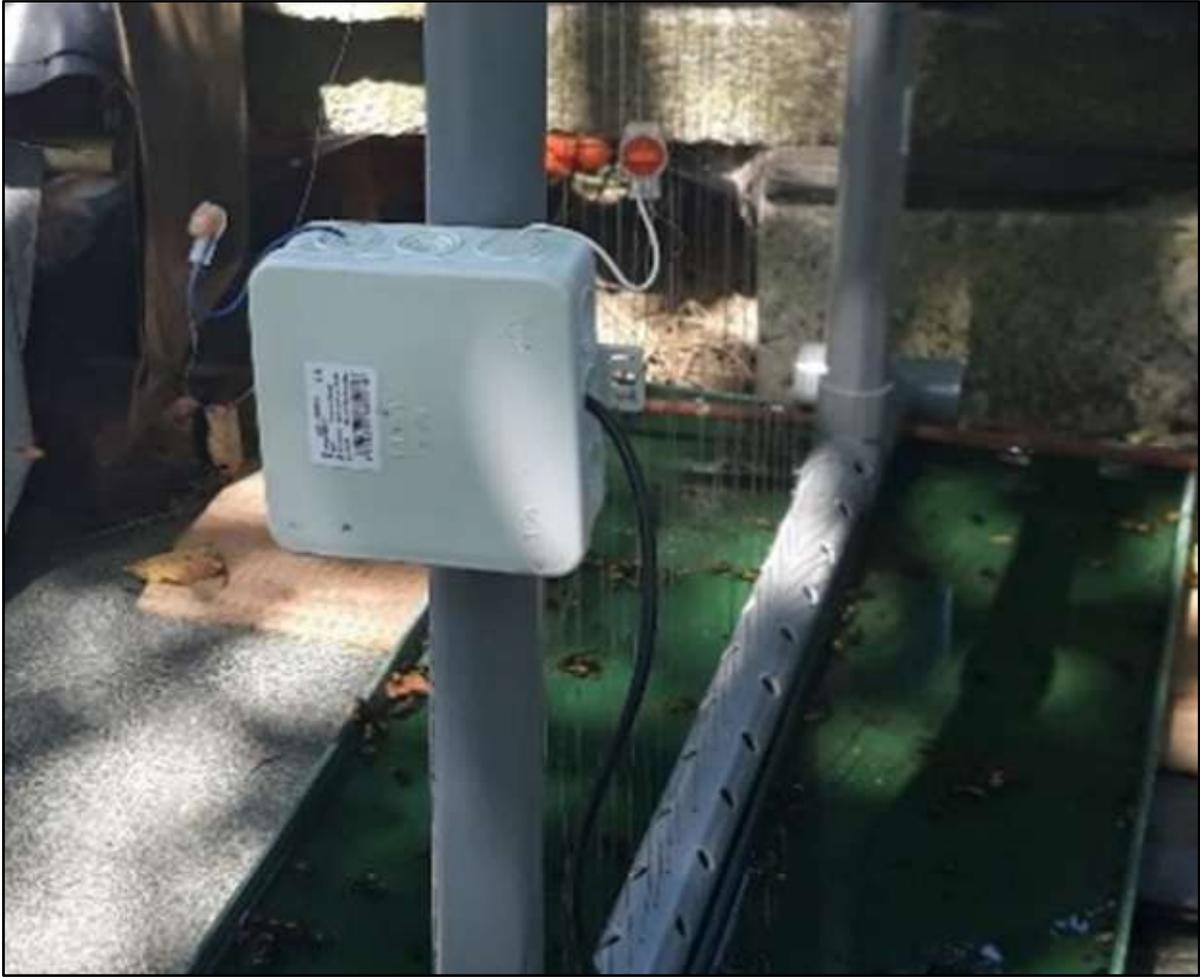
Figure 20 : Boitier de dérivation étanche en place. Vue globale de la boîte de dérivation étanche avec, en haut les connexions des deux fils provenant de la harpe avec les sorties du Module HT bien protégé des chocs et de la pluie dans la boîte de dérivation étanche. (Ndlr, voyez les deux connecteurs téléphoniques bien dressés vers le haut pour éviter tout risques en cas de pluie)
