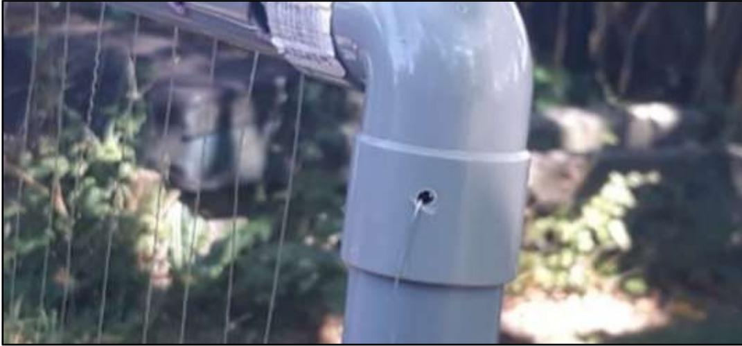
Figure 18 : Suite côté pile de la fixation du début du 1<sup>er</sup> fil, celui partant du haut. Un 2<sup>ème</sup> petit trou de ce côté pile ! Ceci afin de « fixer » au tube la partie du 1<sup>er</sup> fil qui va vers le Module HT.
